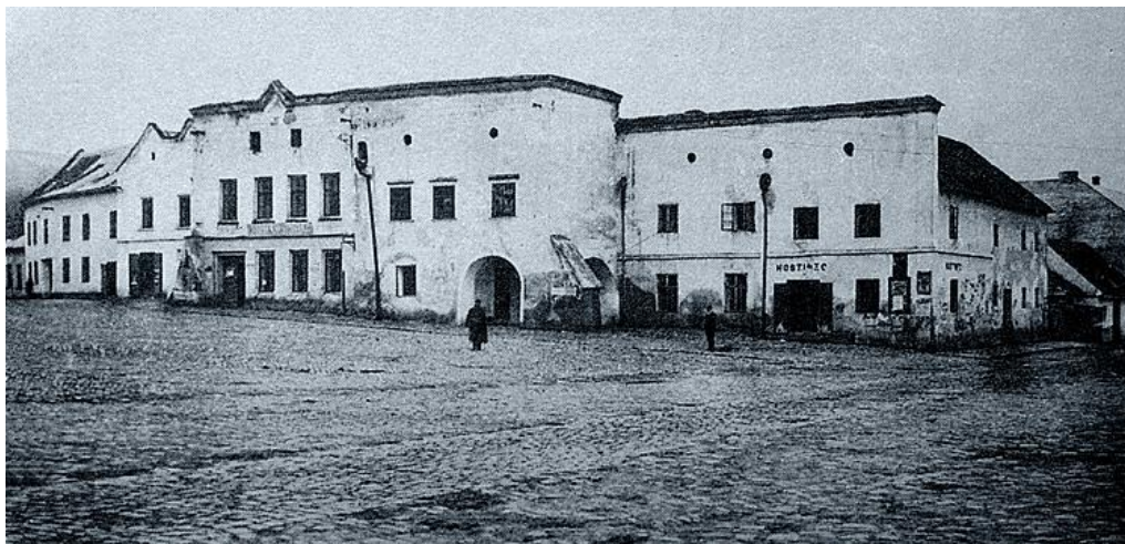
VLEVO BUDOVA RADNICE, VPRAVO HOSTINEC „NA ROŽKU“ DNES JE V TÉŽE LOKALITĚ SITUOVÁNA RESTAURACE DOLCE VITA.
